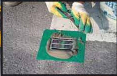
5. ทำการเทพูนแต่งผิวให้เรียบ เสร็จแล้วแกะเทปกาวออก
